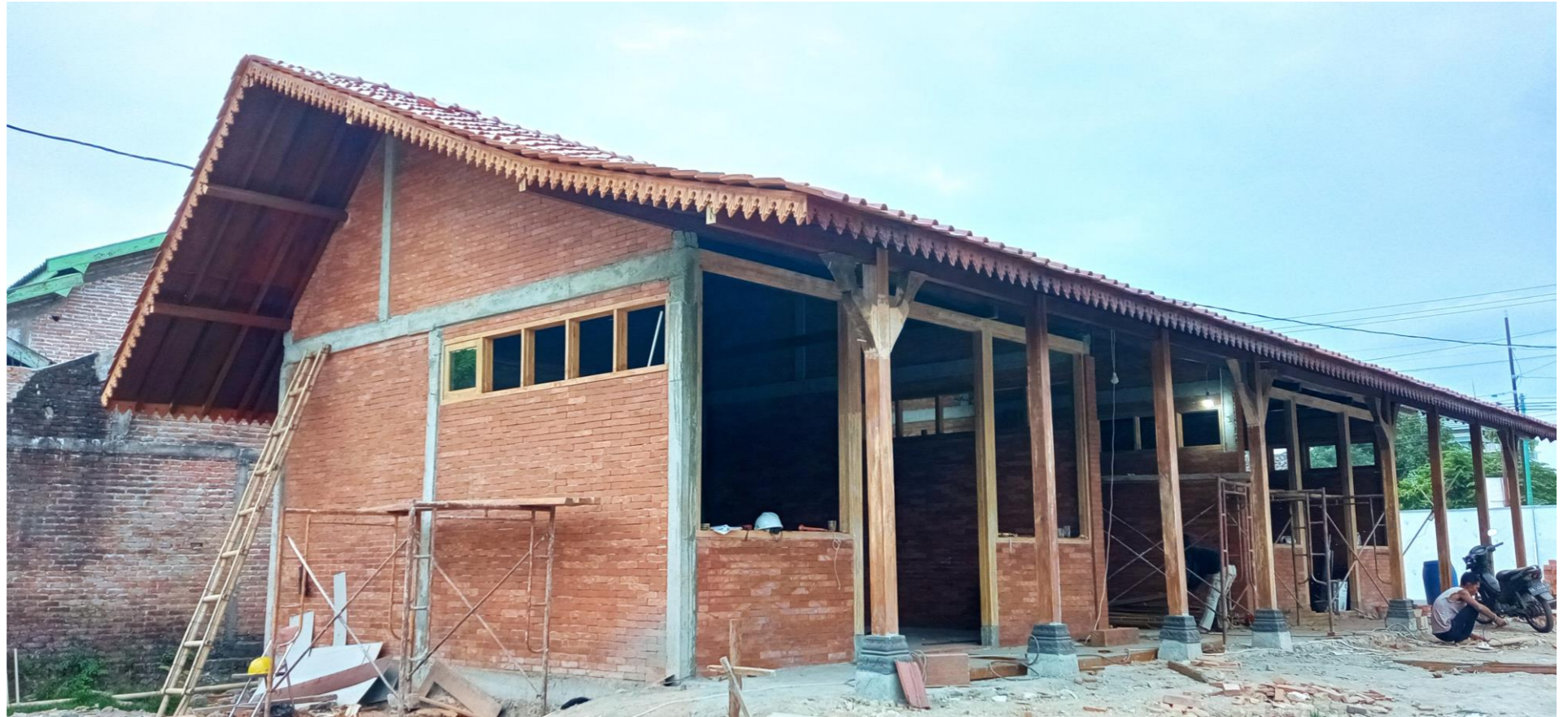
Bangunan Audio Visual Dari Sisi Selatan
