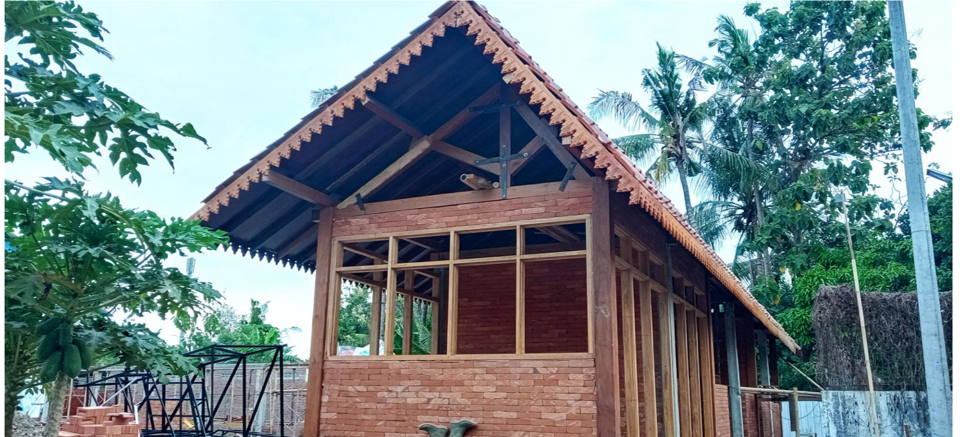
Bangunan Kantin dan UMKM Tampak dari sisi utara
