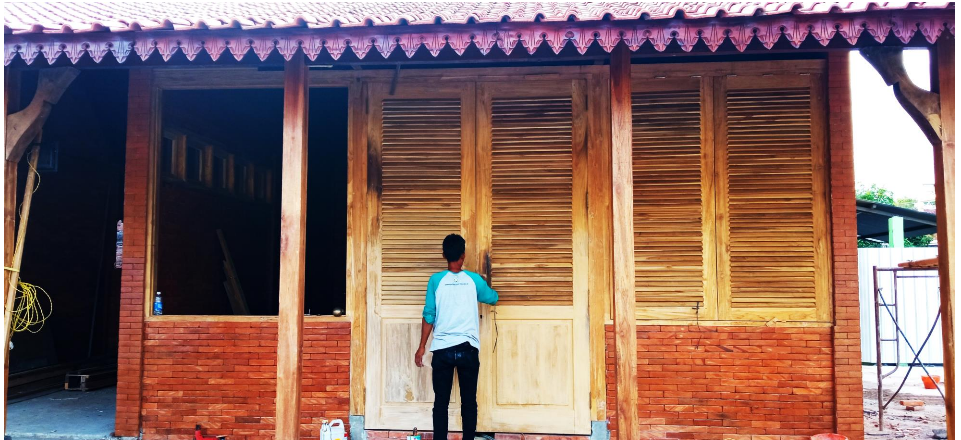
Bangunan Audio Visual Gambar pemasangan daun pintu dan jendela
